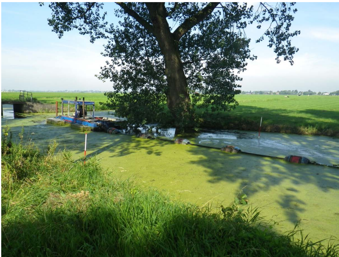
Afbeelding 2. Baggeren met cutterzuiger in veenweidegebied
